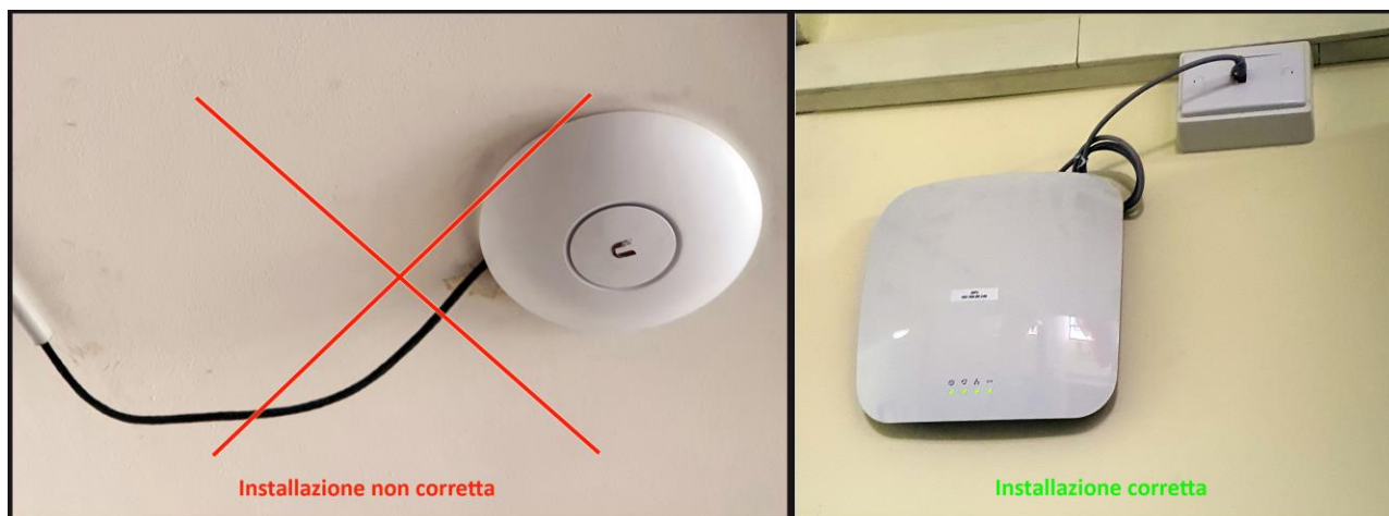
Figura 10 – Installazione corretta dell'Access Point
